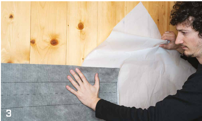
3 Die Trennschicht entfernen und die Bahn von oben nach unten an den Untergrund andrücken.
