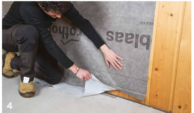
4 Die zweite Trennschicht entfernen und von der Bahnmitte aus an den Untergrund andrücken.
