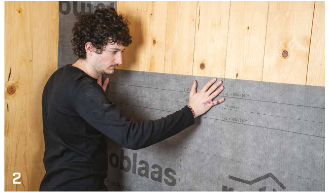
2 Die Bahn abrollen und auf die Platte auftragen. Einen Roller verwenden, um die Haftung am Untergrund zu verbessern.
